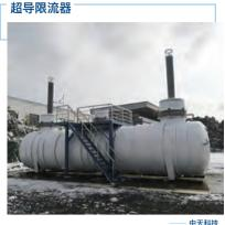
·使用上海超导的 12mm 不锈钢封装高温超导带材, Ic(77K, s.f.) 250A
