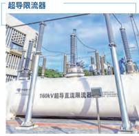
· 使用上海超导的 12mm 双层封装高温超导带材, Ic(77K, s.f.) 500A
